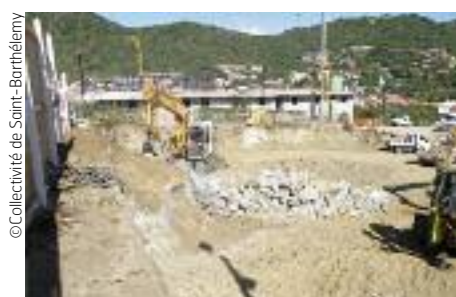
Travaux de terrassement EHPAD
